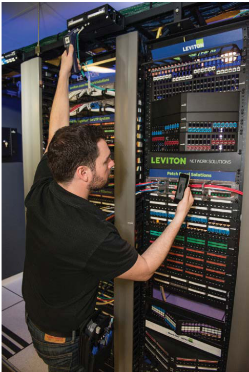
FiberChekプローブの端面映像をスマホで見ている
